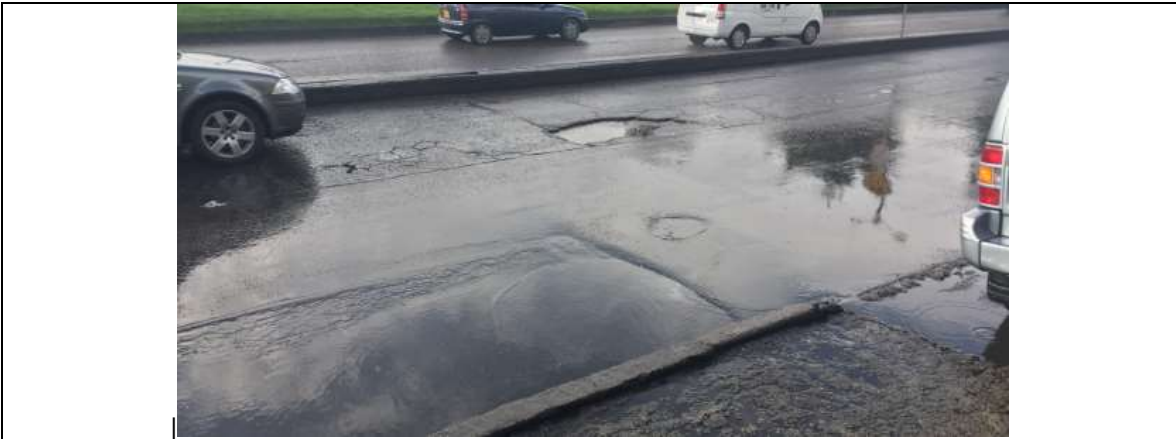
Fotografía 7: Parche ubicado en la Carrera 68 #9-64, se presenta un fallo en el parche y se observa daño estructural del pavimento en la cercanía al parche.
